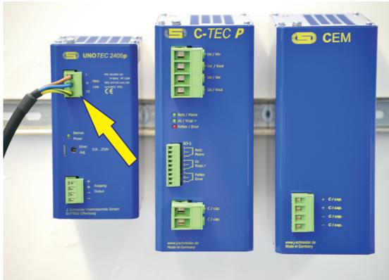
Anschluss des 24 V DC Netzgerätes an das Versorgungsnetz (230 V AC)
