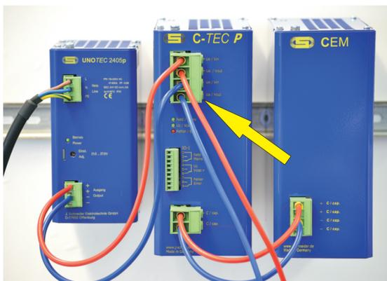
Anschluss der Last an den gepufferten 24 V DC Ausgang des C-TEC P
